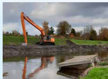
Pogłębienie koryta Bystrzycy. [2021–2022]
